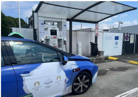
Station d'avitaillement en hydrogène taxis Source EPT
