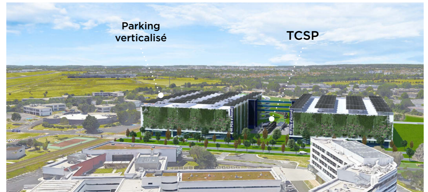
Illustration d'un parc de stationnement, implantation possible à Orlytech (photo non contractuelle).
