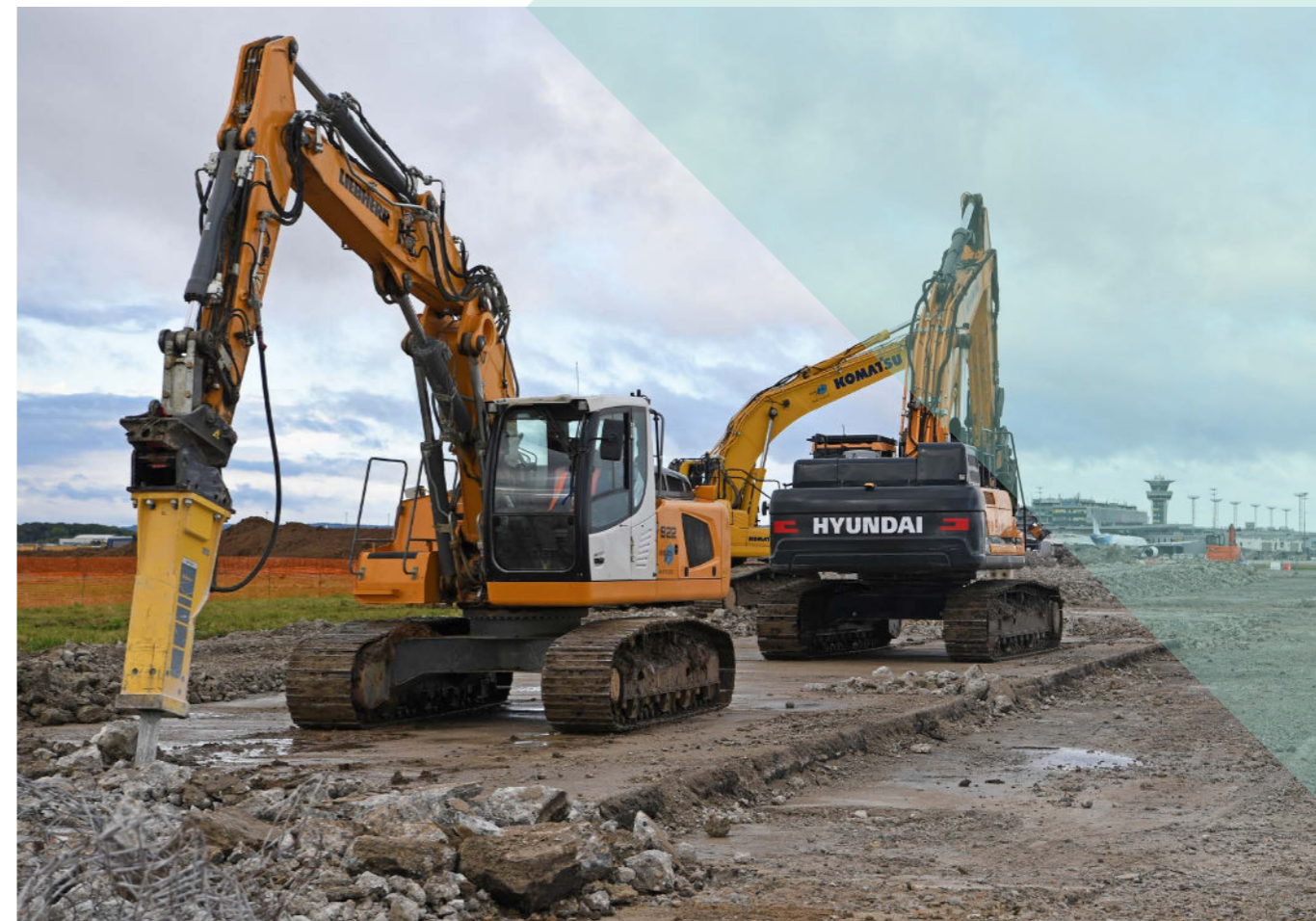
Travaux de rénovation d'infrastructures sur l'aéroport Paris-Orly.
