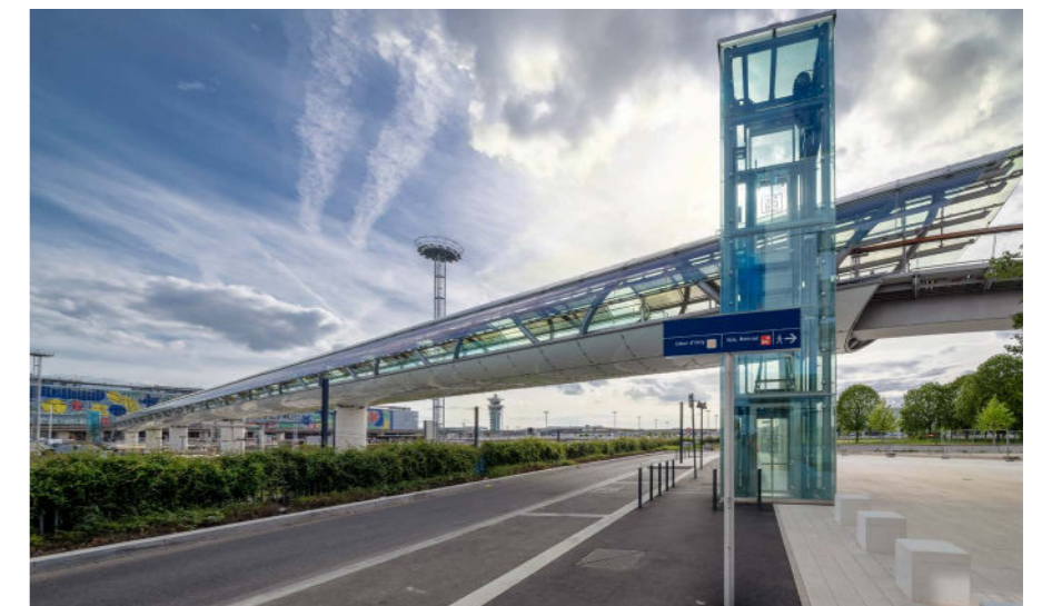
Vue de la passerelle Cœur d'Orly, Paris-Orly.
