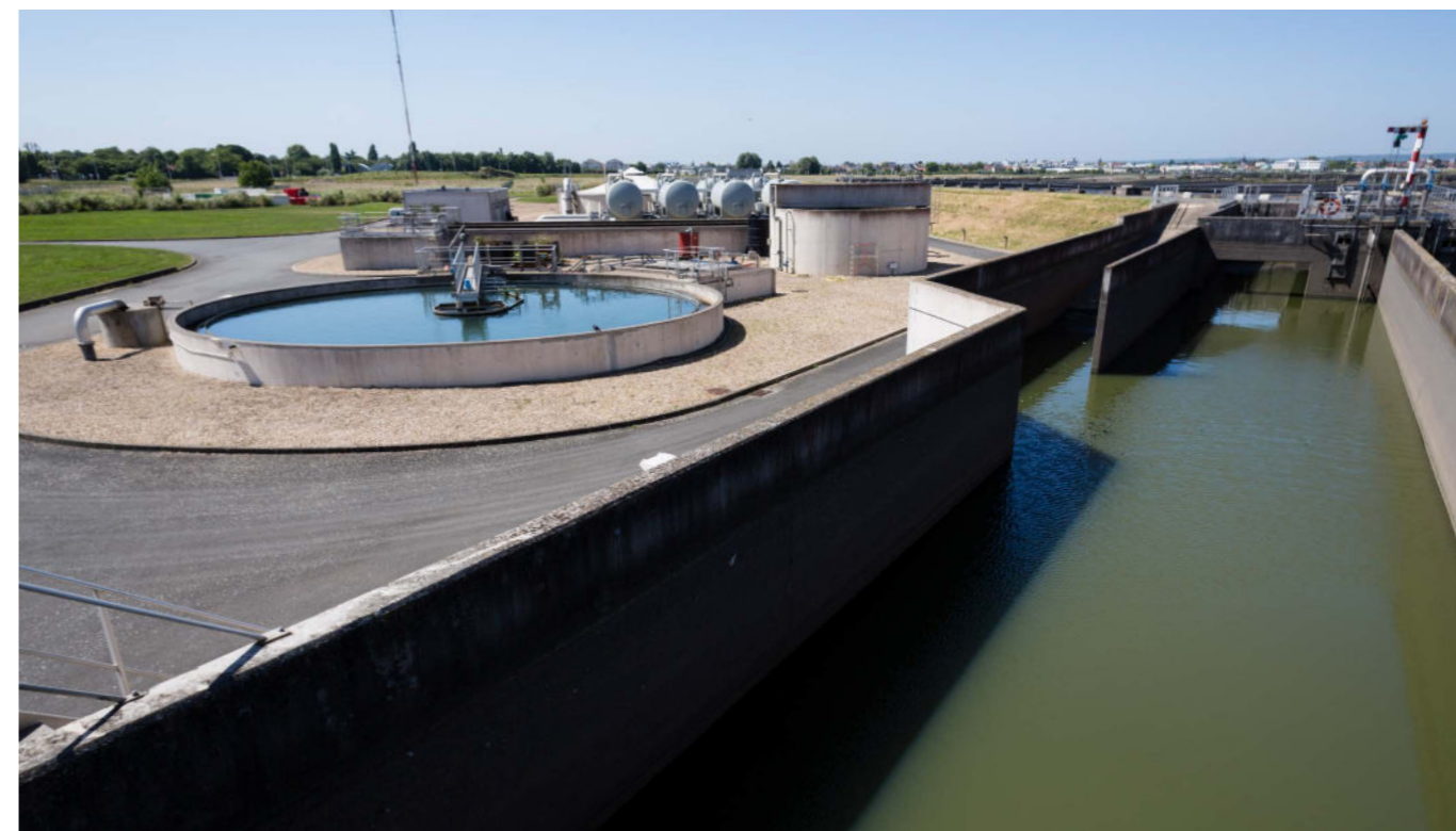
Système de traitement des eaux pluviales (STEP), Paris-Orly.
