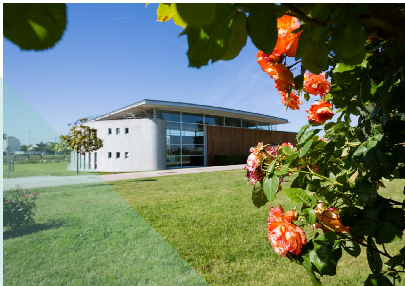
Maison de l'environnement de Paris-Orly.
